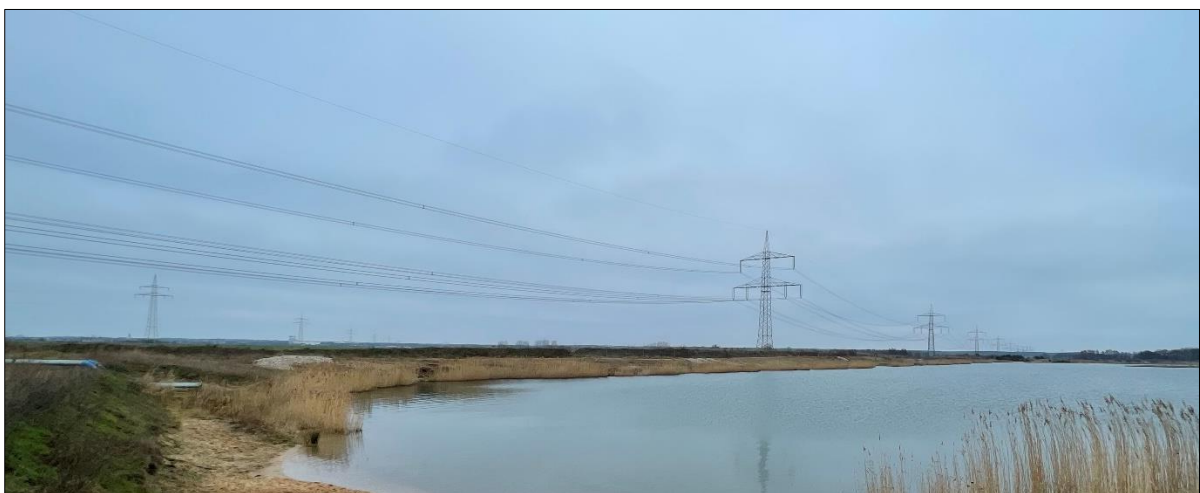
Abb. 11: Freileitungsmasten im nördlichen Blickfeld vom Plangebiet ausgehend
